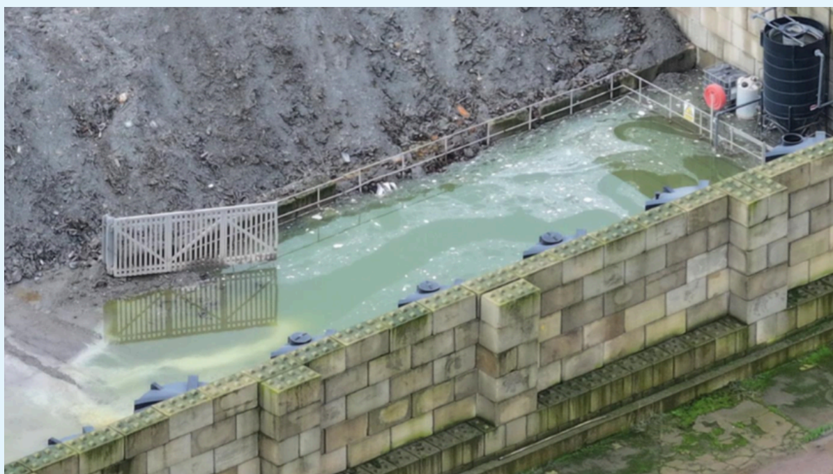
Figura 5. Laguna en las instalaciones de procesamiento de las IBA en Cambridgeshire, Reino Unido, adyacente a las pilas de acopio de IBA. 11
